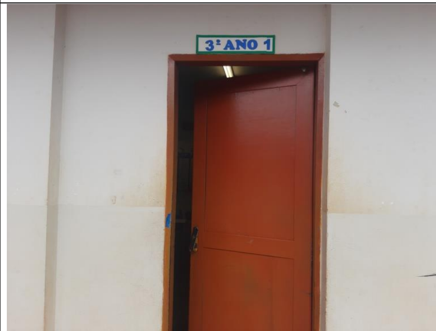
Porta sala de aula – Trocar fechadura
