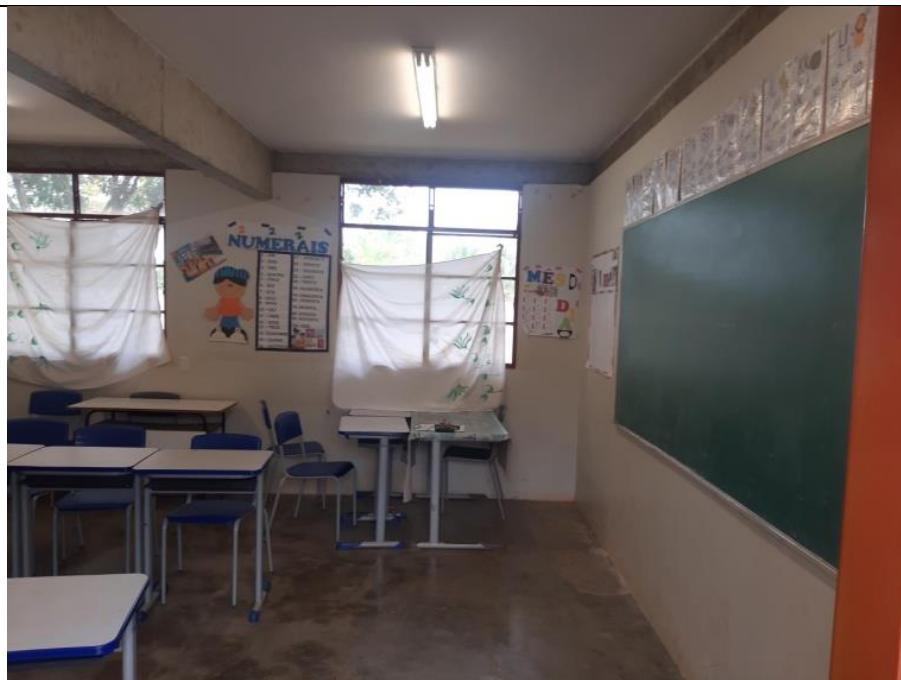
Sala de aula – Pintura
