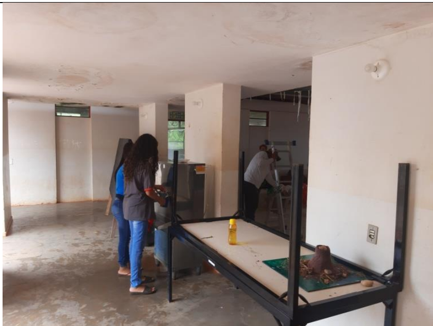
Circulação – Pintura Teto e Paredes
