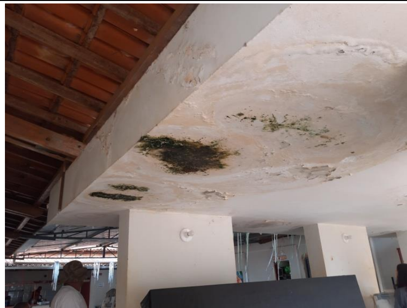
Laje com infiltração – Execução de impermeabilização da laje
