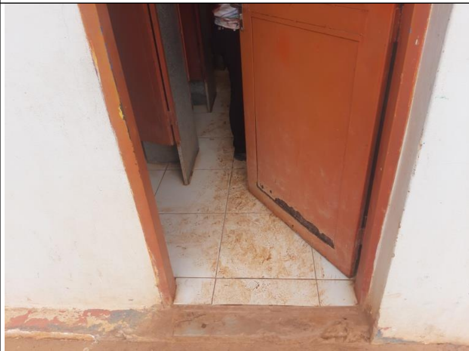
Porta Sanitários - Pintura
